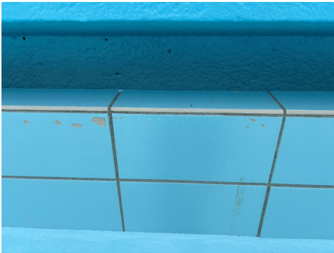
Afbeelding 01 – overloopgoot met glazuurgebreken in diverse stadia
