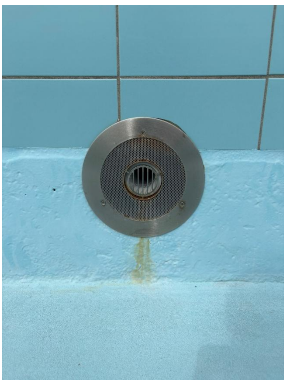
Afbeelding 10 – bij partiële foliebekleding dienen de zwemwater invoerpunten functioneel te blijven.
