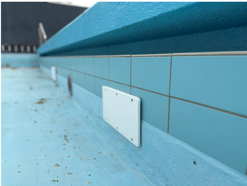
Afbeelding 09 – overloopgoot ondiepe deel, bij partiële foliebekleding dienen de meetwateropnamepunten functioneel te blijven.
