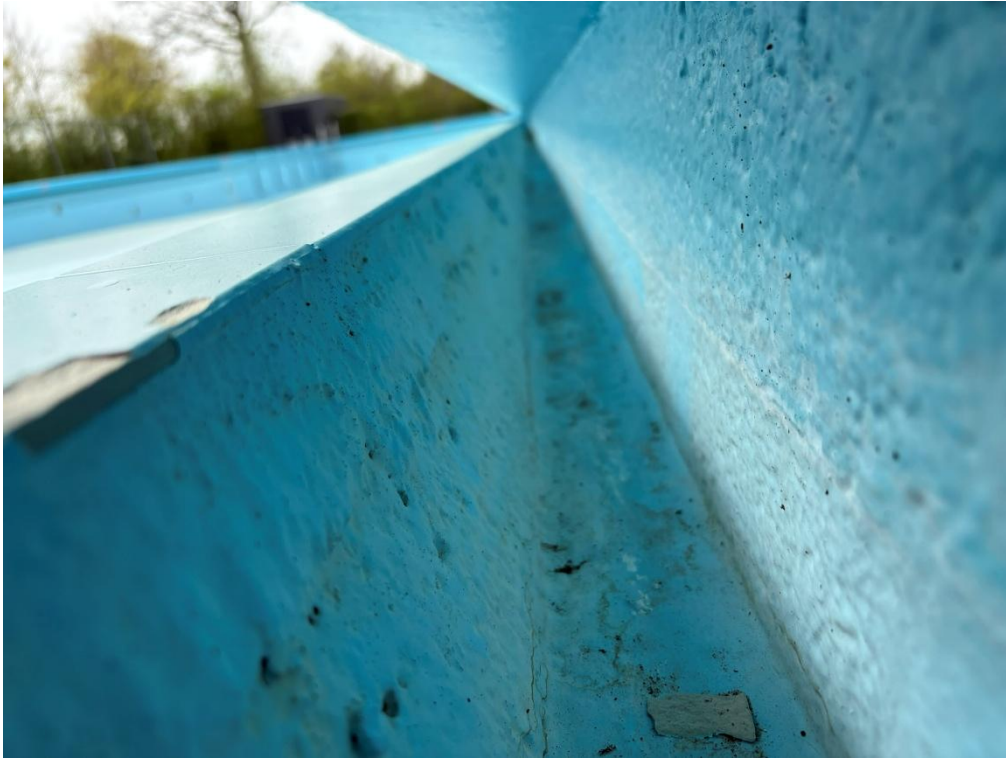
Afbeelding 05 – binnenzijde overloopgoot, het oppervlak is ruw (deels beton, deels een cementgebonden mortel, voorzien van zwembadcoating).
